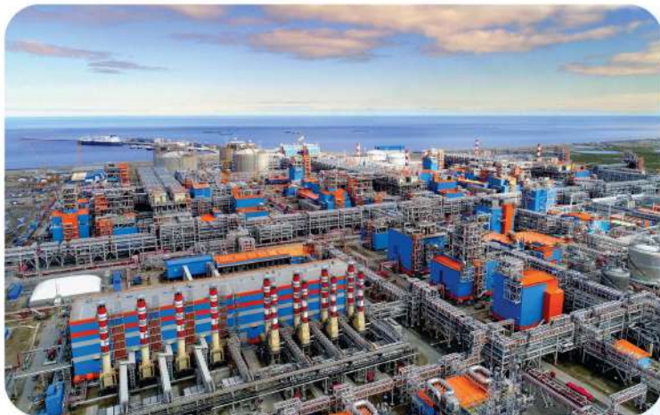
Центр строительства крупнотоннажных морских сооружений (ООО «НОВАТЭК-Мурманск») п. Белокаменка
